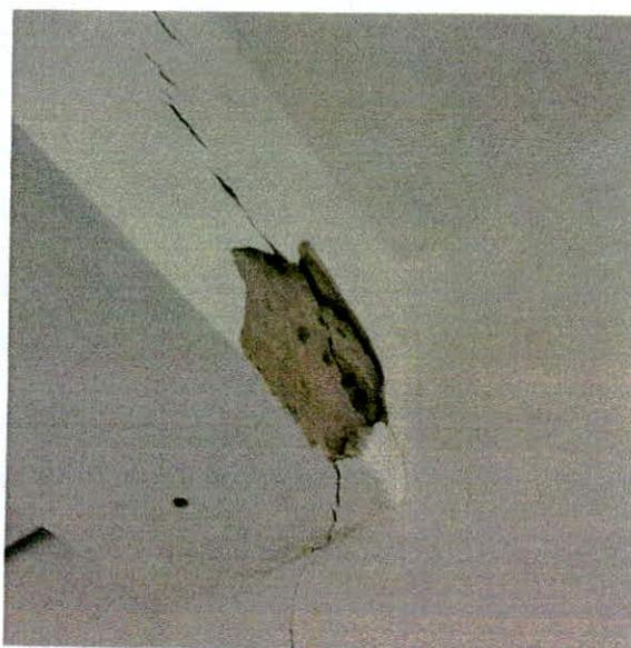
Não foi identificado fissura na estrutura da viga na face em que houve o deslocamento da argamassa de revestimento. Entretanto, na face oposta foi identificado uma fissura vertical, conforme a Foto 3.5.
