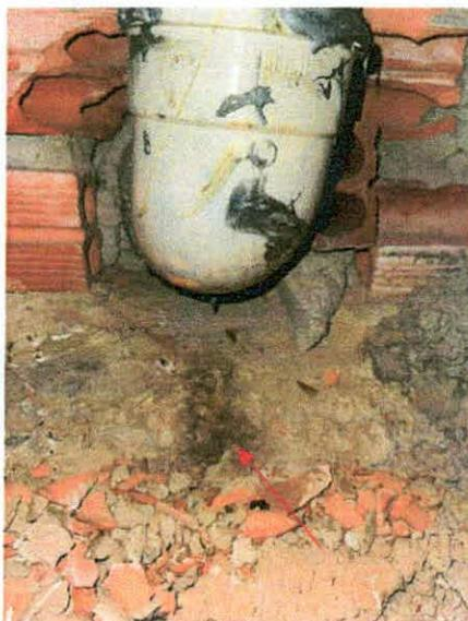
Foto 4.3 - Leitura da umidade através da *moisture pen*.
