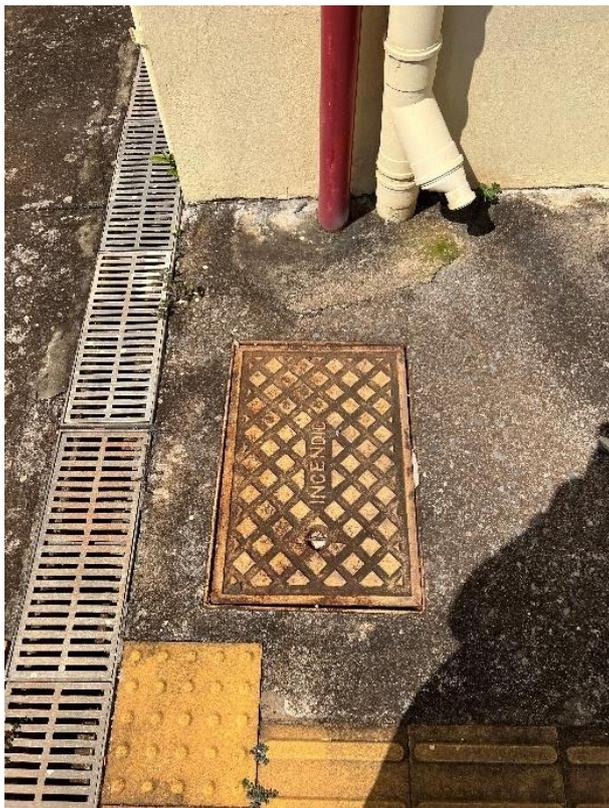
Figura 6 - Engate do sistema de combate a incêndio (será construído abrigo)
