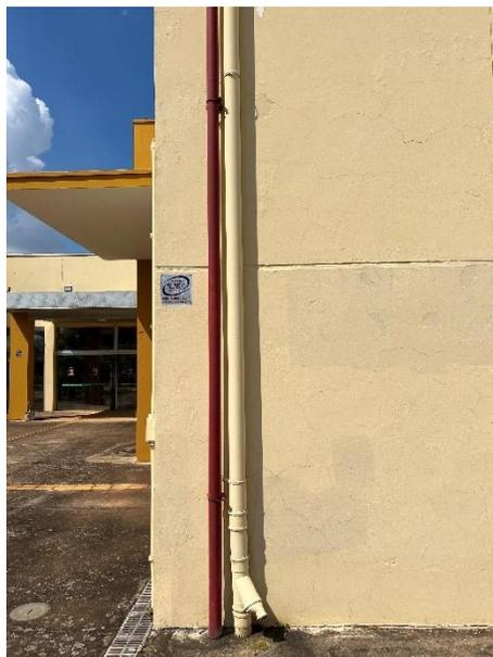
Figura 5 - Tubulação de combate à incêndio e coluna pluvial (será executado shaft)
