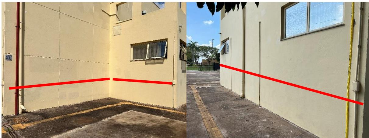
*Figura 3 - Diferença de nível (piso externo/interno) onde será construído embasamento de 80cm*
