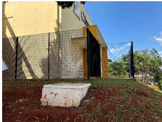
*Figura 9 - Gradil a ser realocado (será necessária a construção de um complemento para o contra-piso).*
