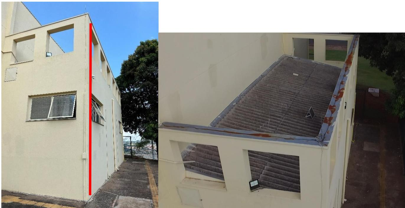
Figura 7 - SPDA a ser realocado para parede lateral
